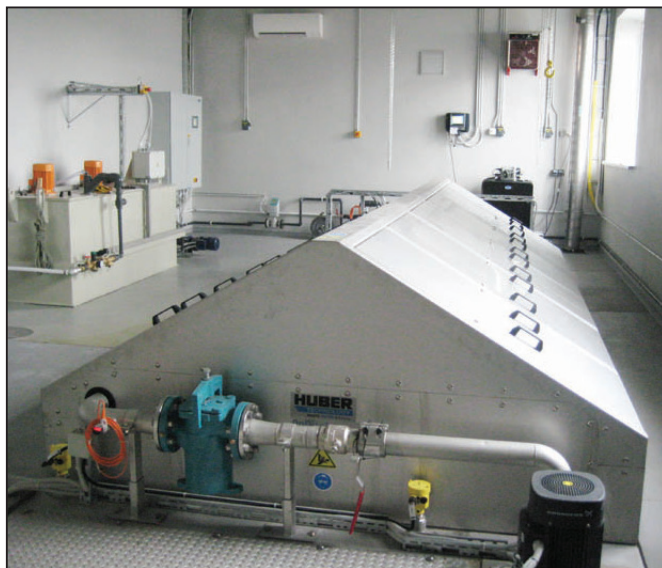
RVP järefiltratsioonisüsteem
