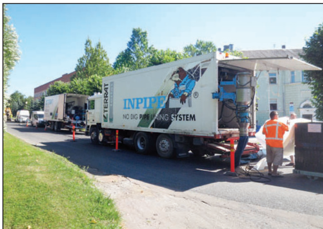
Kajaka tn kanalisatsioonitorustik
